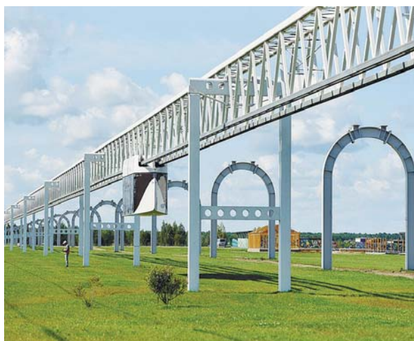
Рис. 4. Путьевая структура SkyWay жесткого типа (рельсо-струнная ферма для движения как подвесного, так и навесного подвижного состава). Марына Горка, 2019 г.
