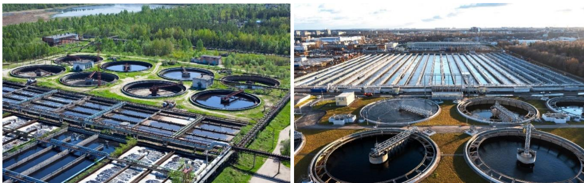
Рисунок 1 – Общий (панорамный) вид очистных сооружений
