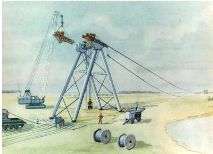
Рис. 14. Натяжение струны на анкерную опору
