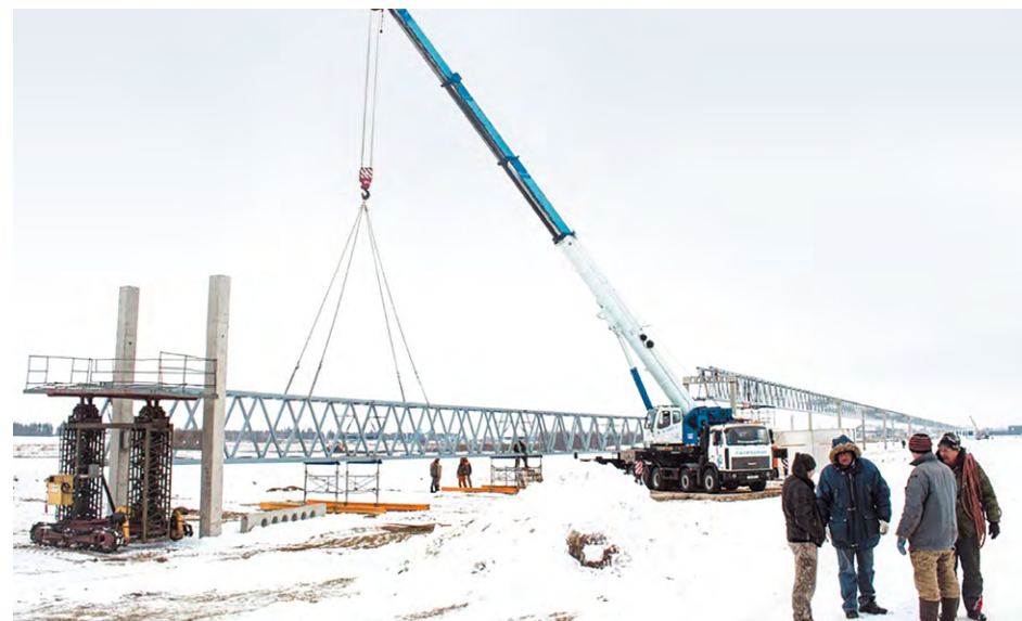
Монтаж ферм путевой структуры городской системы, ЭкоТехноПарк, г. Марьино Горка, февраль 2017 г.
