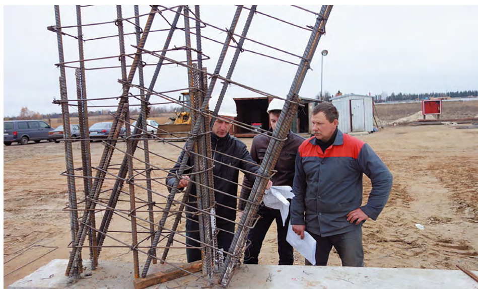
Строительство пилонов первой анкерной опоры высокоскоростного SkyWay, ЭкоТехноПарк, г. Марьина Горка, ноябрь 2015 г.
