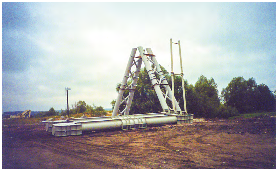
Монтаж узлов второй анкерной опоры на строящемся стенде СТЮ «Путевая структура», г. Озёры Московской области, август 2001 г.
