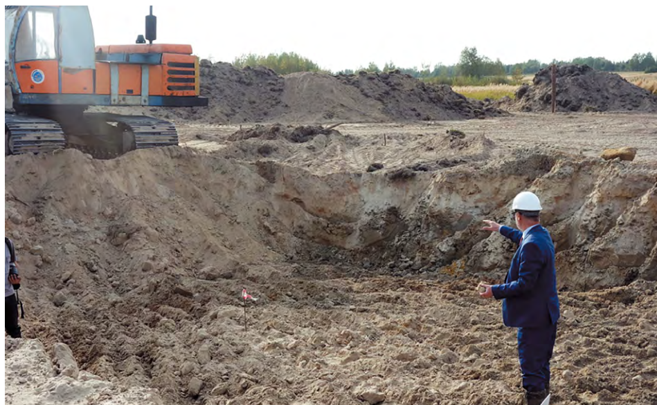
Рытьё котлованов под анкерную опору в ЭкоТехноПарке, г. Марьина Горка, август 2015 г.
