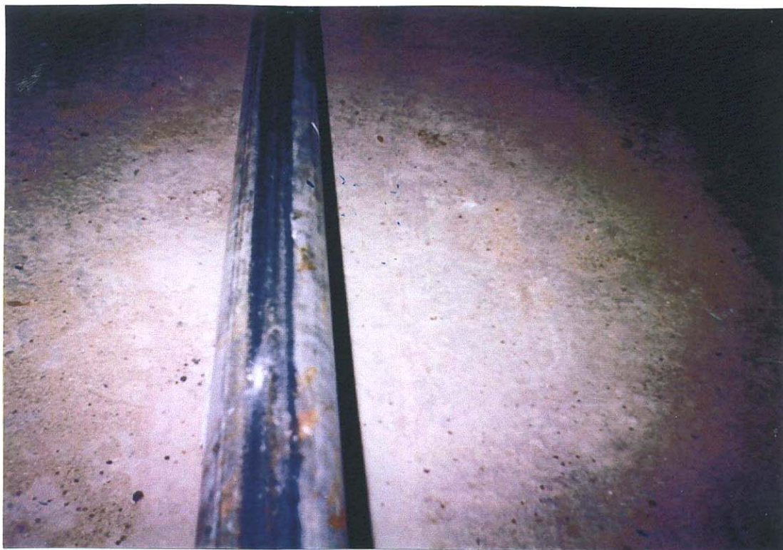
Рис.3.4 Контактная полоса взаимодействия колеса с головкой рельса.
