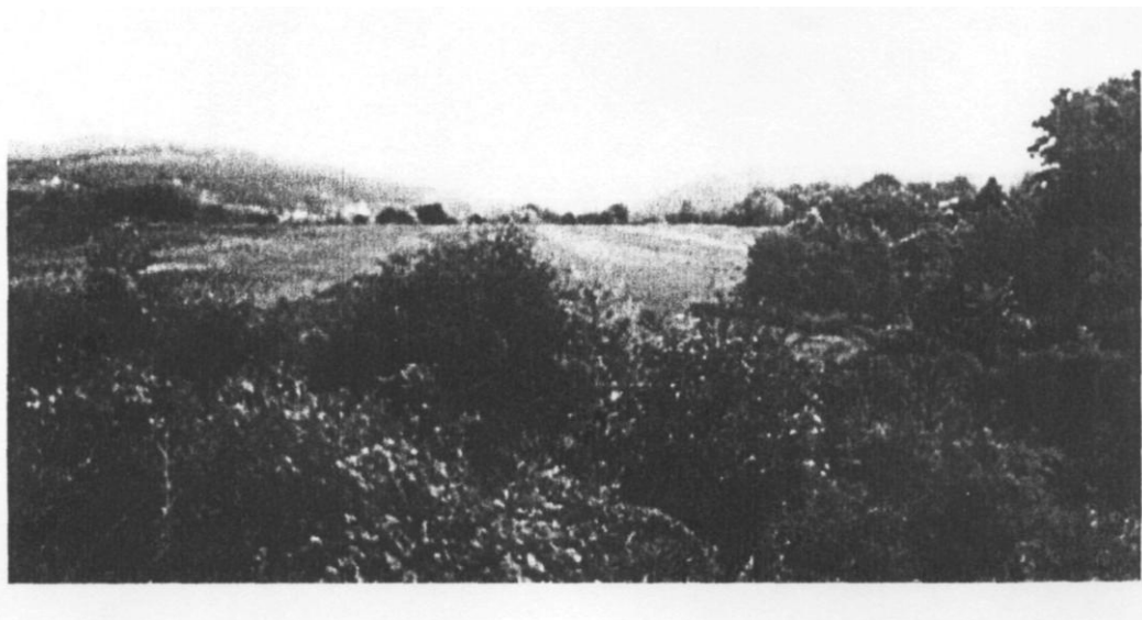
Рис. 1.2.3.1. Общий вид участка строительства СТС в г. Адлере
