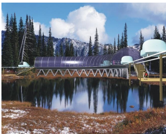
Рис. 22. Поворотная анкерная опора навесного ТСЮ, совмещённая с пассажирской станцией
