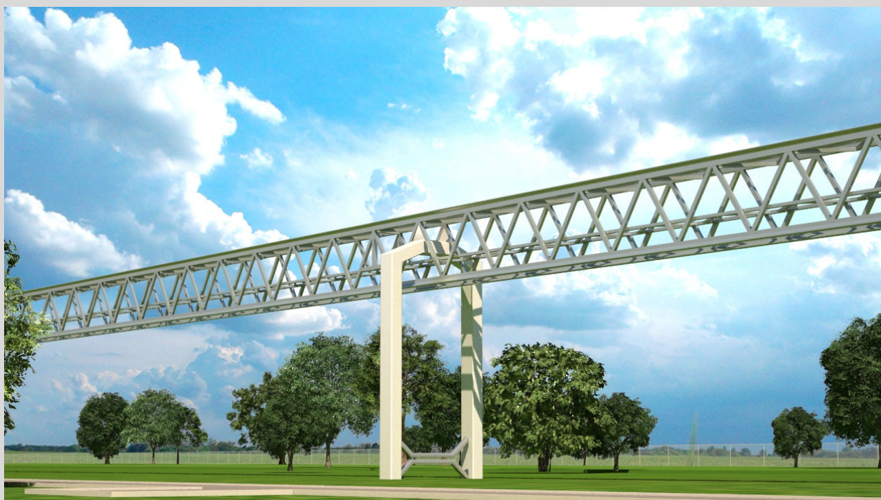
Рисунок 3.9 – Пример струнно-ферменной путевой структуры
