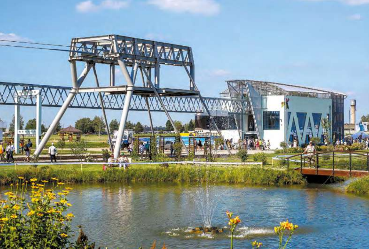
2018 год. Анкерные опоры струнных трасс в ЭкоТехноПарке: одна – в виде здания, другая – стальная каркасная
