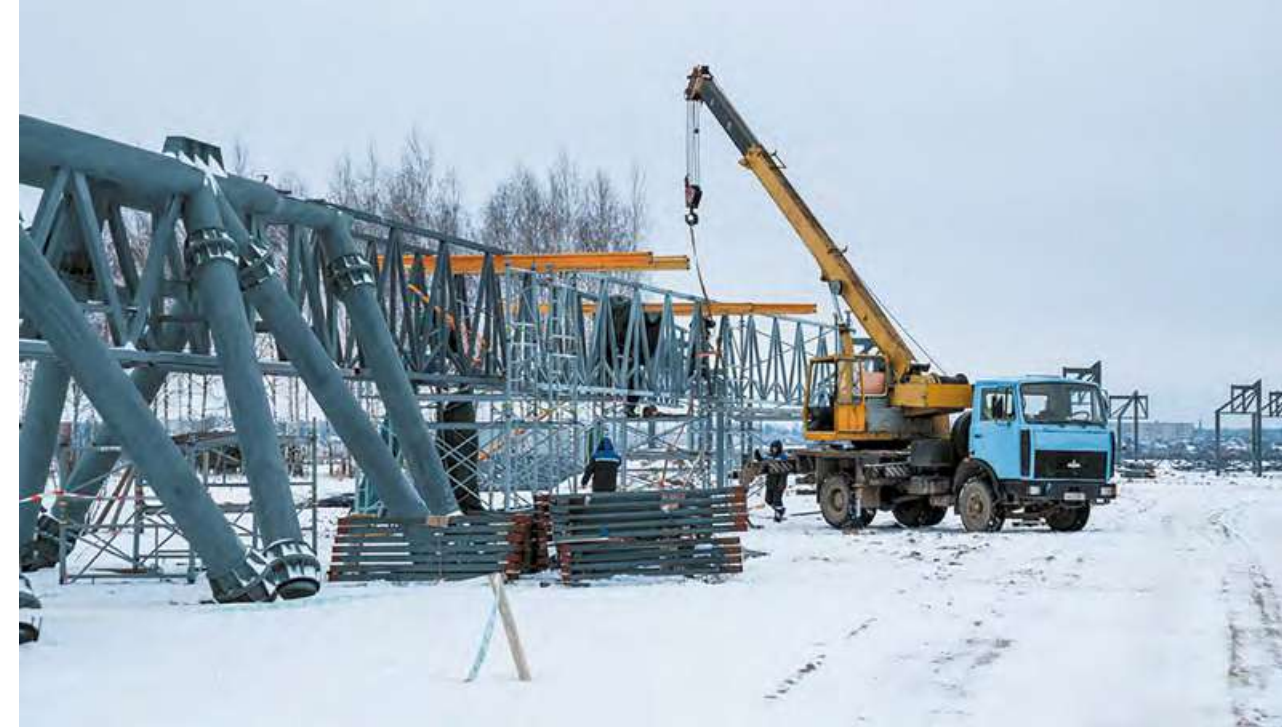
2017 год. ЭкоТехноПарк. Строительство грузовой трассы
