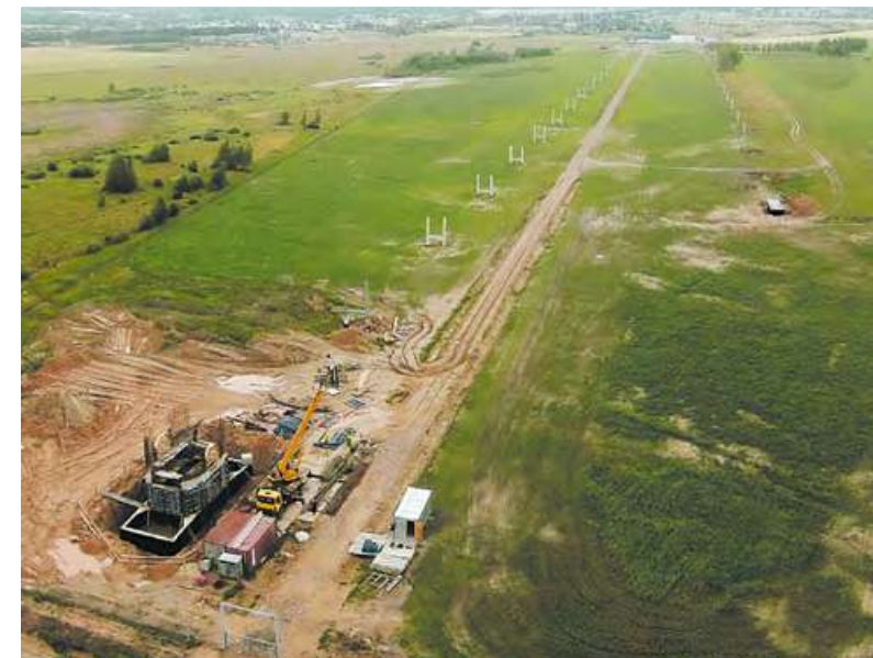
Испытательно-демонстрационный центр «ЭкоТехноПарк». Начало строительства (2015–2016 годы)
