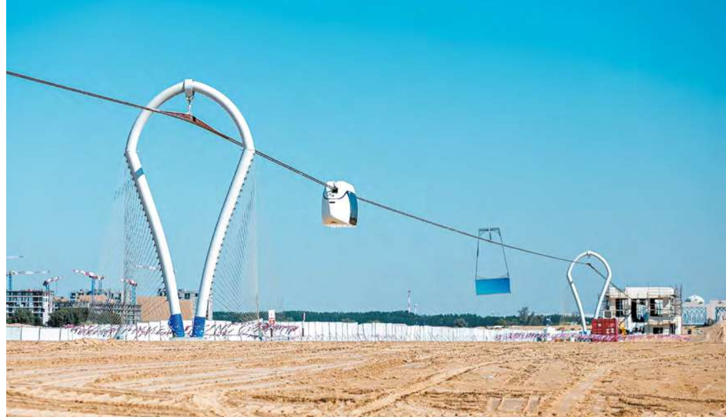
2019 год. Строительство струнной трассы в Шардже (ОАЭ)
