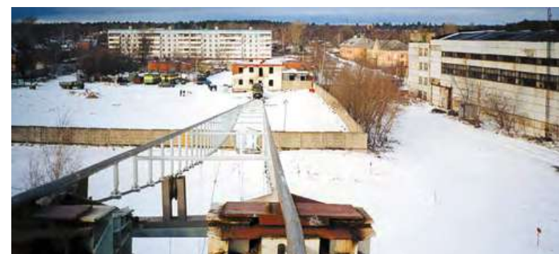
2002 год. Проведение зимних испытаний струнного транспорта на Озёрском полигоне
