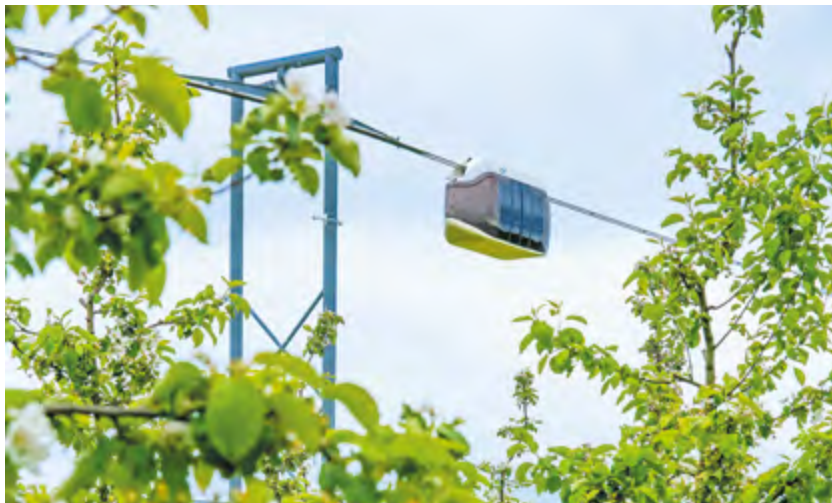
2019 г., Марьина Горка. R&D-центр «ЭкоТехноПарк»: из юникара открывается живописный вид на сад, растущий прямо под трассой. Струнный транспорт не уничтожает природу, а мирно соседствует с ней
