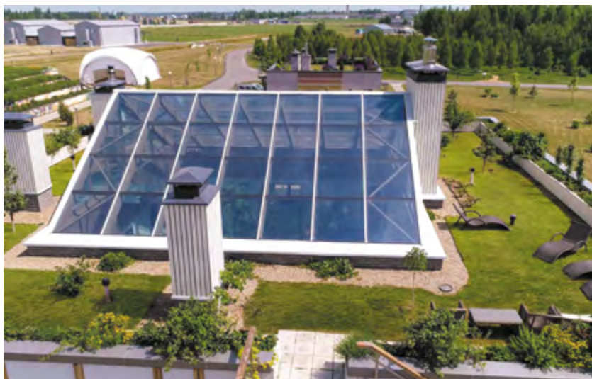
2020 г., Марьина Горка. R&D-центр «ЭкоТехноПарк»: «зелёная» крыша экоддома
